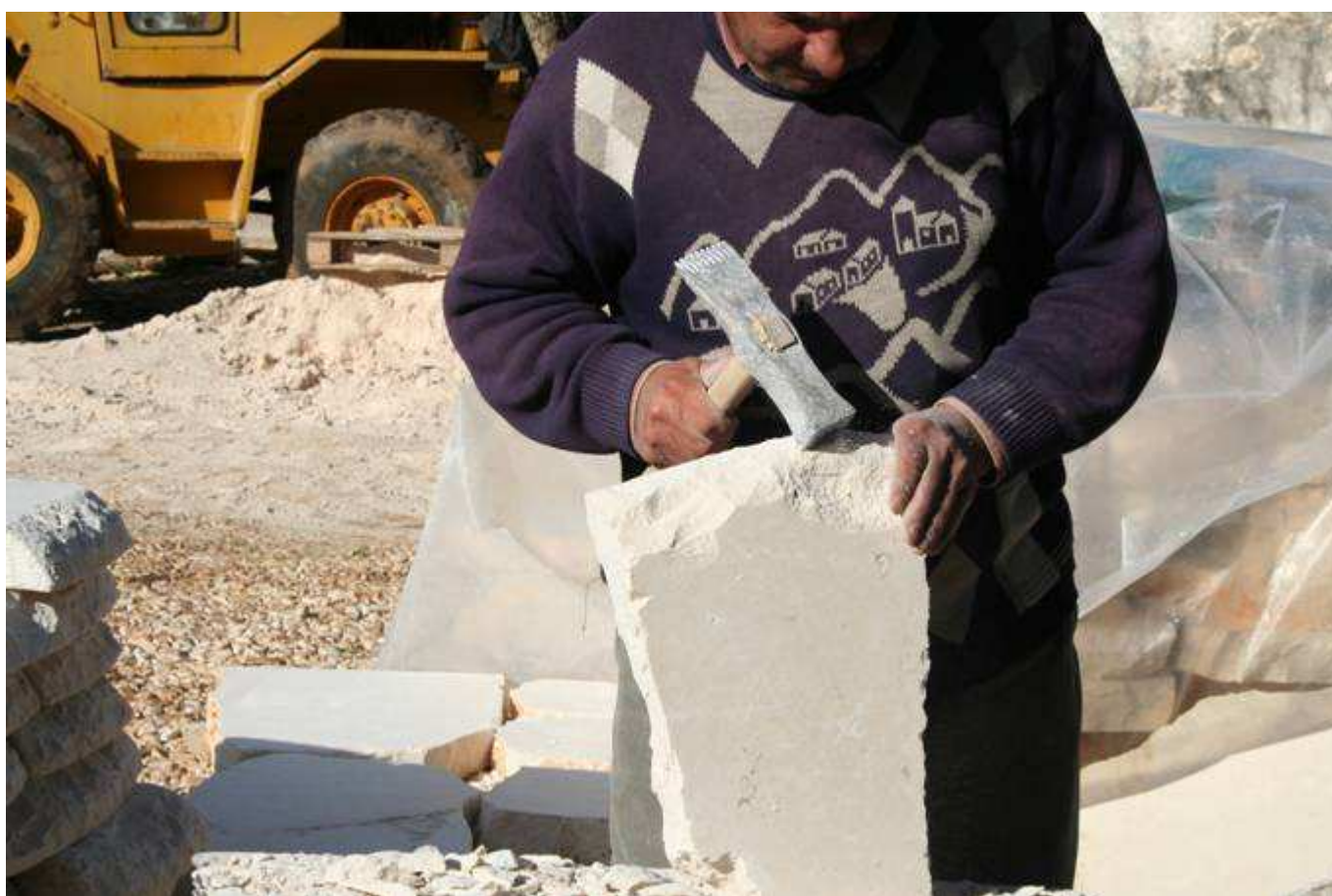
Il montaggio prevede la integrazione di lastre nuove lavorate a mano una per una
