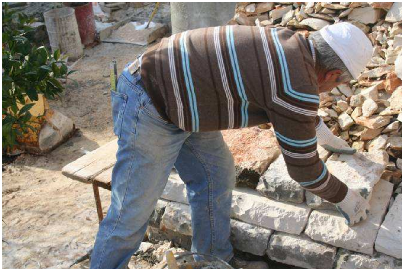
La disposizione delle lastre avviene a secco sfruttando il peso dei conci che ne assicurano la stabilità nel tempo
