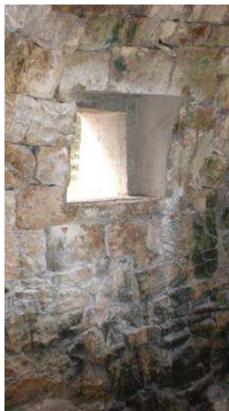
Particolare delle pietre interne dove risultano evidenti avanzati processi di degrado
