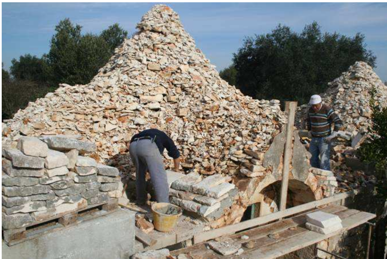
Il montaggio prevede la integrazione di lastre nuove lavorate a mano una per una
