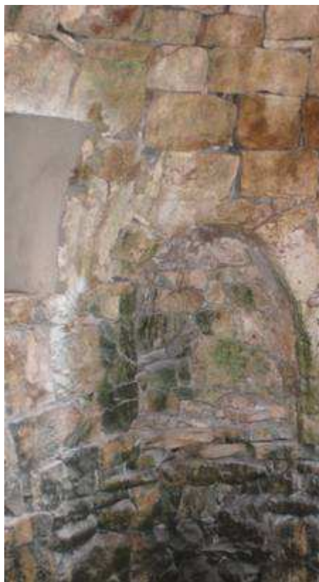
Particolare delle pietre interne dove risultano evidenti avanzati processi di degrado
